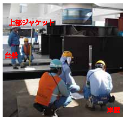
図 - 18 水盛り計によるレベル差確認作業
