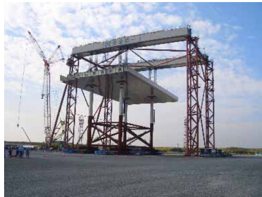
図 - 1 4 富津工場における上下部ジャケット一体化
