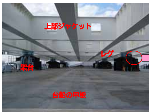
図 - 19 台船上での固縛状況
