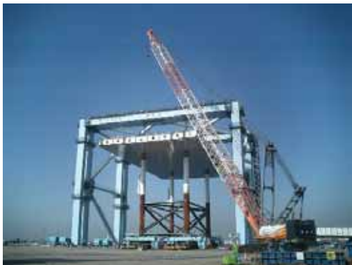
図 - 1 3 千葉工場に置おける上下部ジャケット一体化
