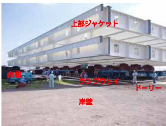
図 - 17 ユニットドーリーによる搬送
