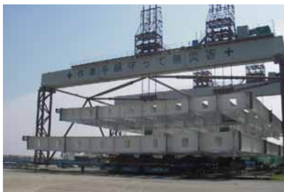
図 - 16 搭載架構による2段積み
